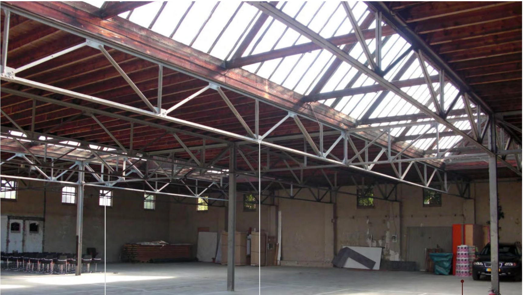
ramen in buitenmuur
