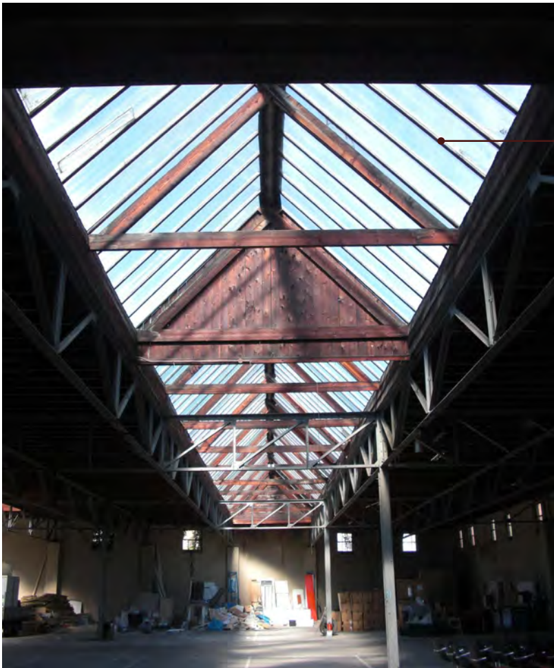
tussen de liggers zijn grote dakramen voorzien
