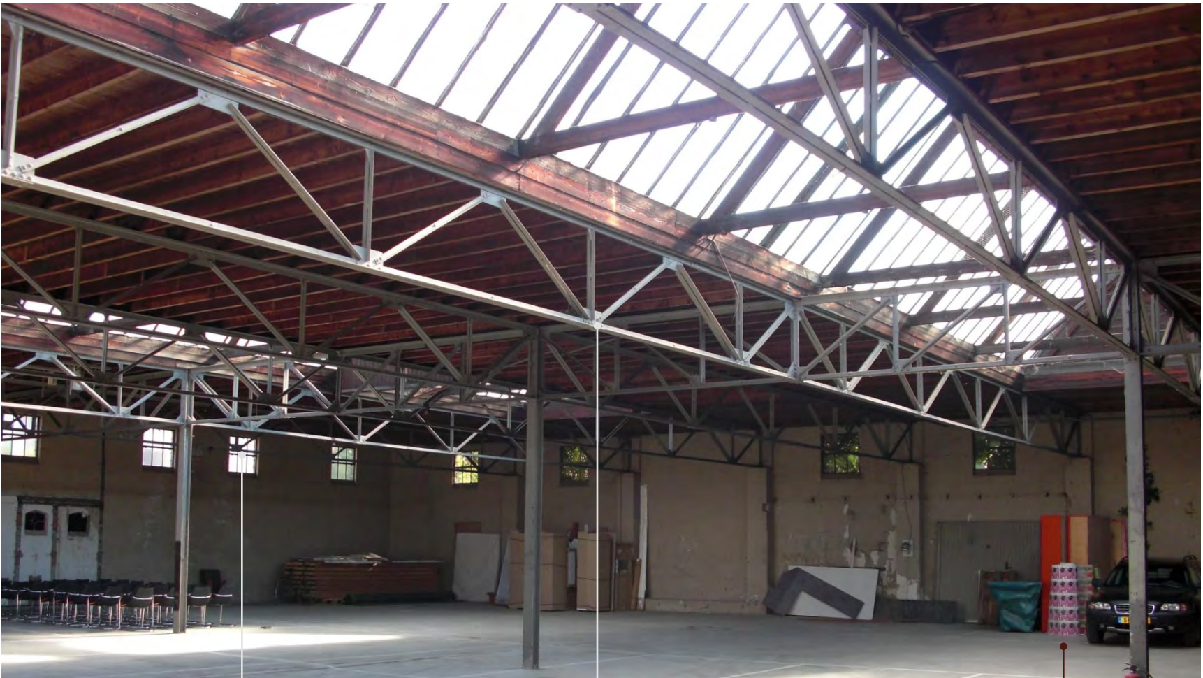
ramen in buitenmuur
